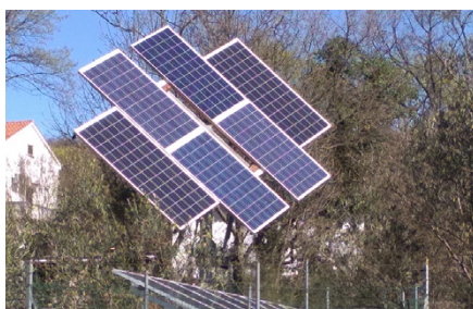
Postavljanje na rotirajuću metalnu konstrukciju "solarni suncokret"
