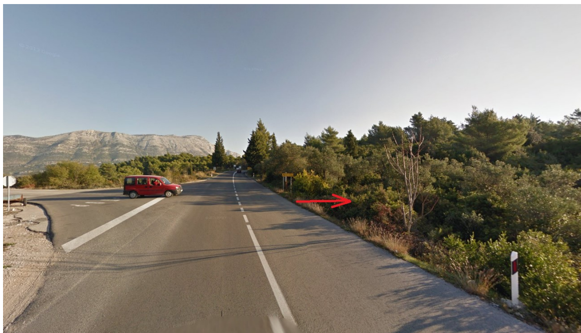
fotografija mjesta priključka GZ Lokva
